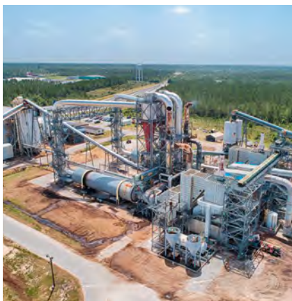
Produktionsanlage von Enviva: Waycross plant, Georgia (USA)
